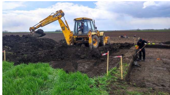
2. kép. A termőréteg eltávolítása gépi munkaerővel
